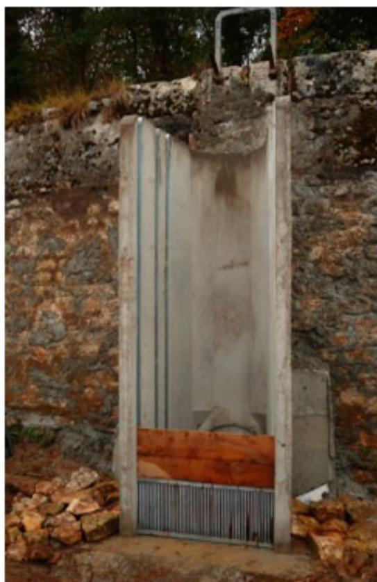
Figure 31 : Exemples d'ouvrages réglables constitués de batardeaux en bois
