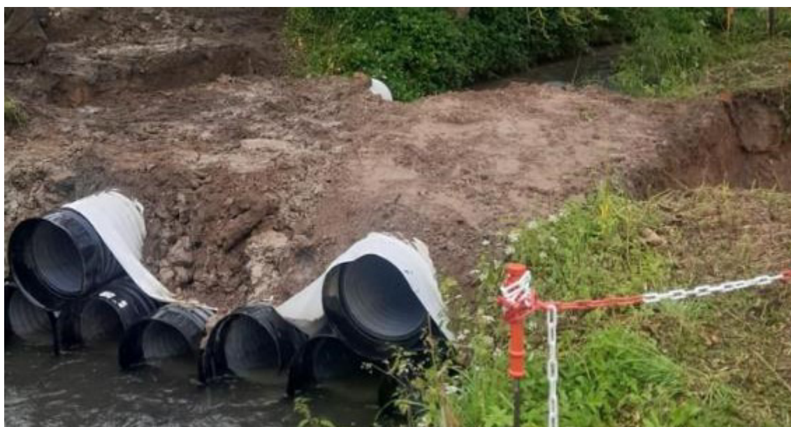
Figure 34 : Exemple de franchissement provisoire de lit mineur
