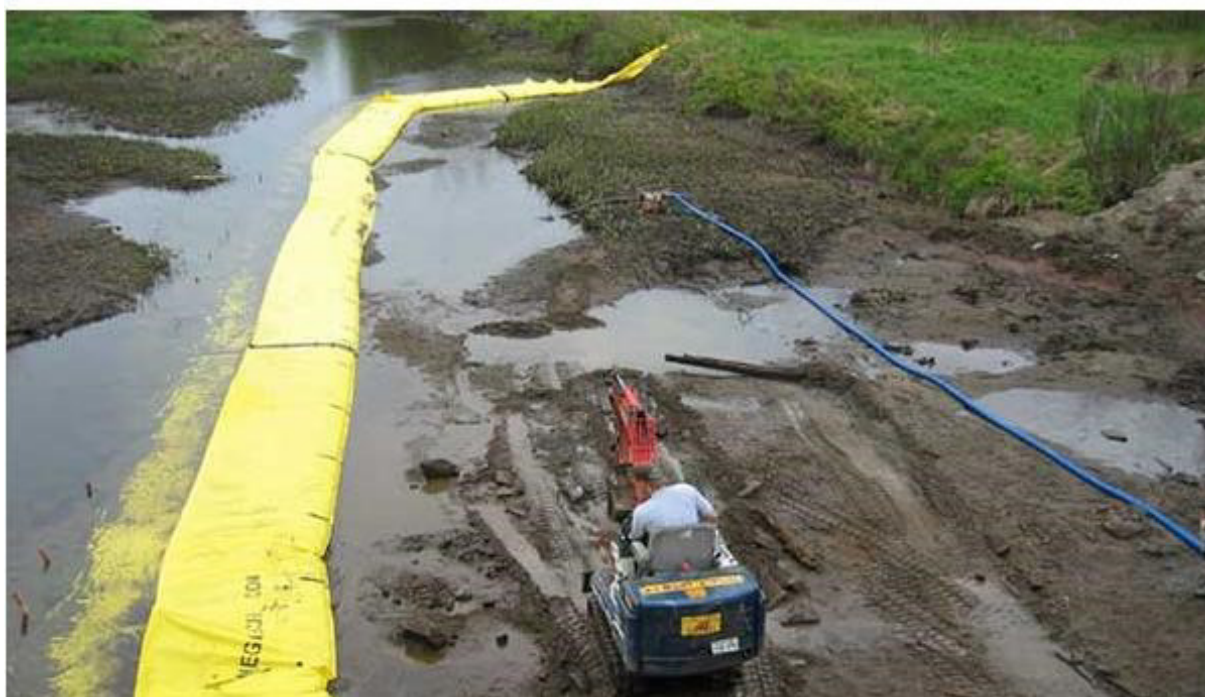
Figure 35 : Exemple de batardeau flottant
