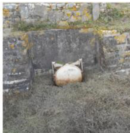
Clapet anti-retour à déposer et bassin béton à curer
